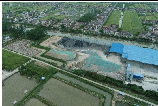
110kV 升压站站址
